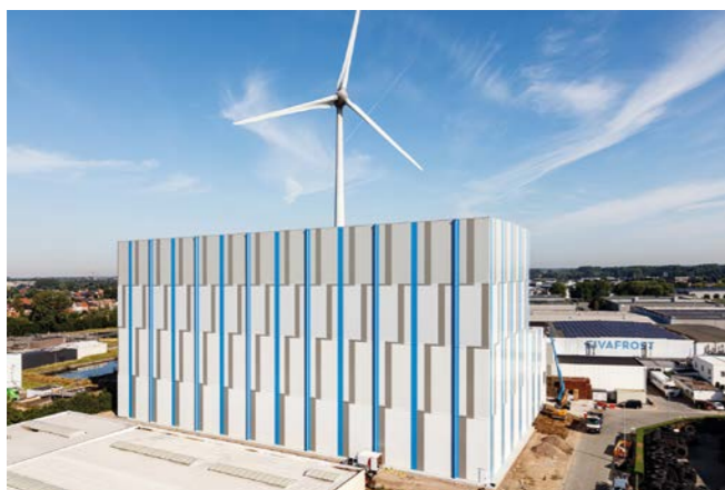
Het nieuwe hoogbouwmagazijn wapent Sivafrost voor de toekomst. (© Alheembouw)
